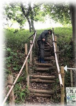
階段補修作業
